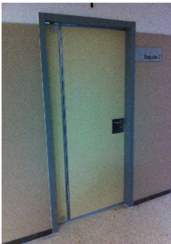
PUERTA VISTA DESDE FUERA
